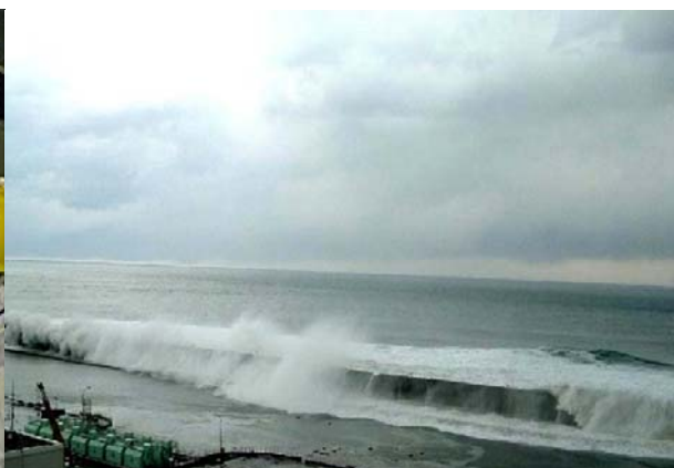
El tsunami y las escolleras en la central nuclear
