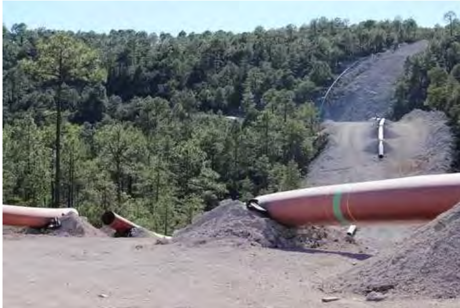
Gasoducto El Encino - Topolobampo. FOTO: M. Breach
